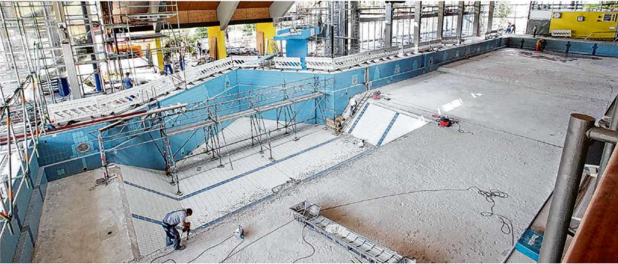
Schon mehrfach wurde das Sportbecken des Schenkensee-Hallenbads saniert. Auf dieser Aufnahme von 2012 sind die unterschiedlichen Tiefen gut zu erkennen. Der Bereich hinten rechts soll nun im Sommer 2026 eine noch geringere Wassertiefe erhalten – sie wird von derzeit 1,50 auf 1,20 Meter verringert. Zudem soll ein Teilstück dieses Bereichs einen flexiblen Hubboden erhalten, der bei Bedarf bis zur Wasseroberfläche hochgefahren werden kann. Der Bereich vorne links mit der Sprungturm-Vertiefung bleibt unverändert. Die beiden Bereiche sollen bei Bedarf mit einer Klappwand voneinander abgetrennt werden können. Foto: Archiv/Ufuk Arslan
